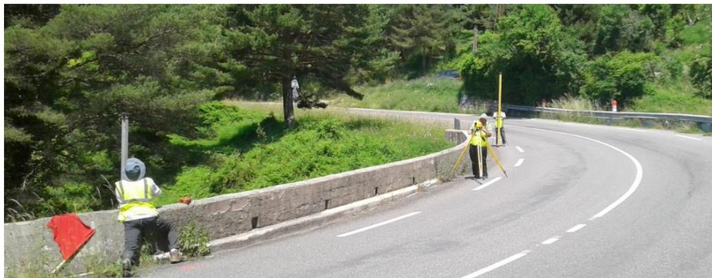
Mesures de dénivelés par nivellement direct
